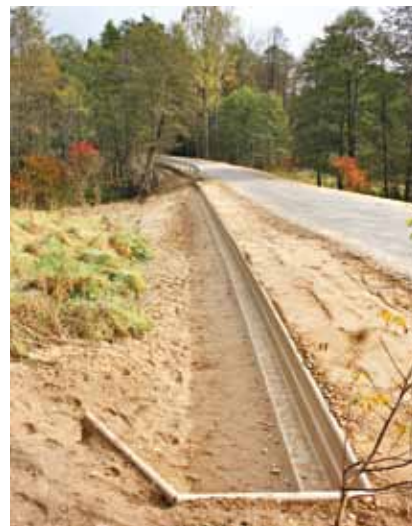
Budowa przepustów dla płazów na terenie WPN-u – Wiatrołuża.
