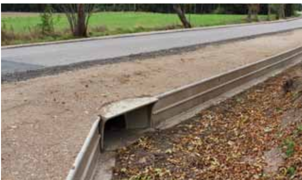
Ukończony system przepustów dla płazów we wsi Krzywe.
