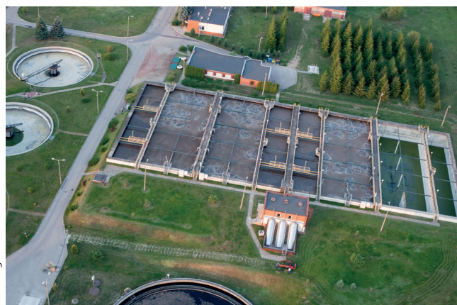
Komory nitrifikacji-denitryfikacji.
