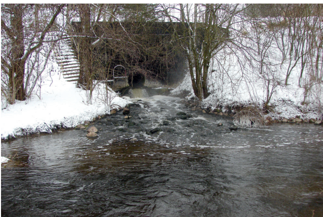
Wylot oczyszczonych ścieków do rzeki.
