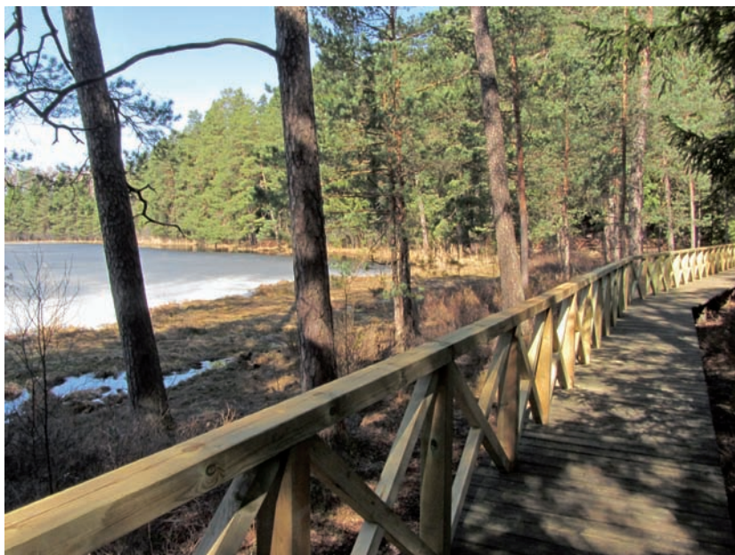
Nowa kładka na ścieżce. Fot. Maciej Kamiński
