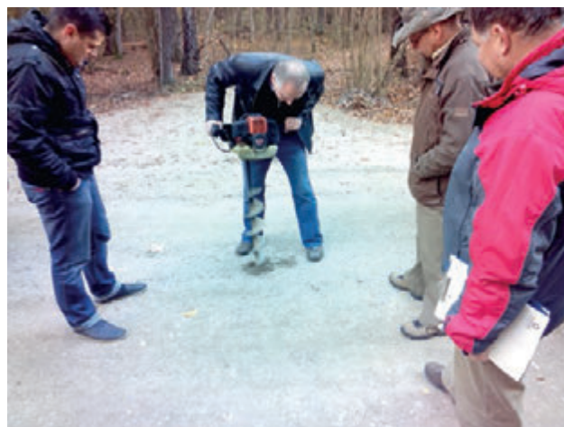
Wykonywanie kontrolnej odkrywki w nawierzchni wyremontowanej drogi. Fot. Zbigniew Tarlecki
