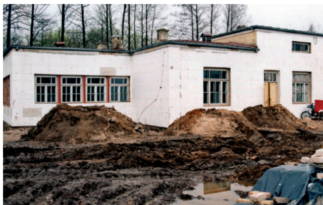
Rok 1998. Zaawansowane prace remontowe i termomodernizacyjne budynku wylęgarni ryb.
