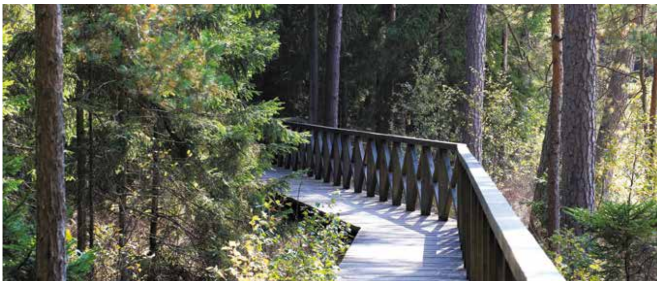
Nowa kładka na ścieżce edukacyjnej „Suchary”.
