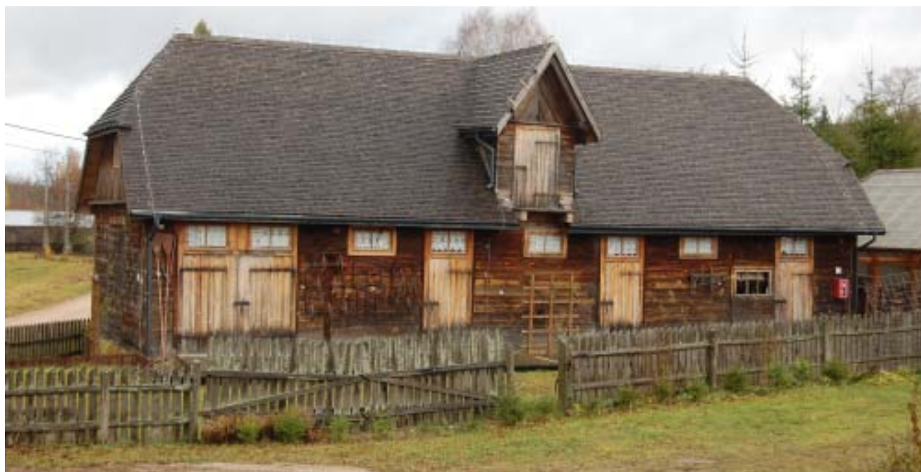
Budynek wystawy przed remontem.
