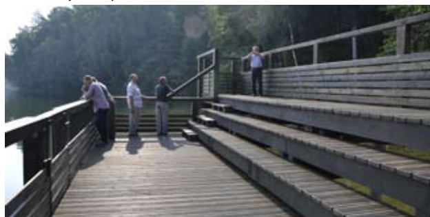
Nowa konstrukcja pomostu widokowego na Bartnym Dole umożliwiła cumowanie statku pasażerskiego.
