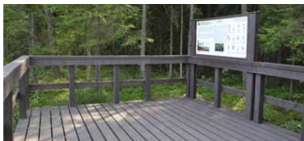
Konstrukcja pomostów widokowych na ścieżce Las wykonana została z materiału powstającego z przerobu tworzyw sztucznych uzyskanych w wyniku recyklingu (z tzw. hanitu). Jest to materiał trwały i odporny na warunki panujące w miejscach podmokłych.
