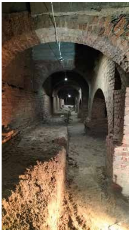
Wnętrze piwnic pod eremami tarasu dolnego w Wigrach
